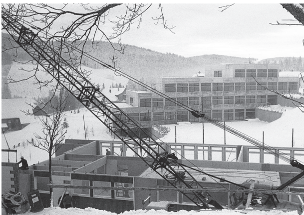
012_Ev. Kindergarten, Montage bei Winterwetter, 1968
