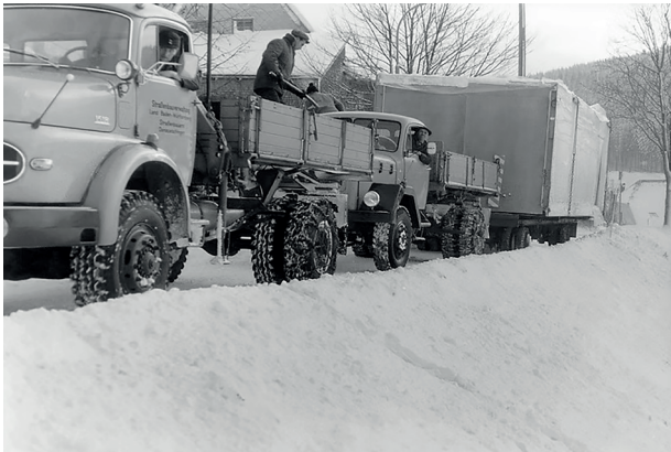
010_Ev. Kindergarten, Straßentransport Raumzelle, 1968
