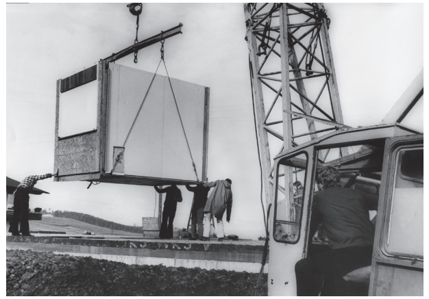
017_ FF-Typenhaus_Montage Raumzelle
