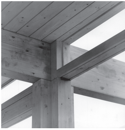
033_FF-Modulsystem_Kreuzstützen-Knoten
