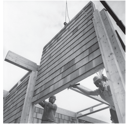
036_FF-Modulsystem_Montage Wandelemente
