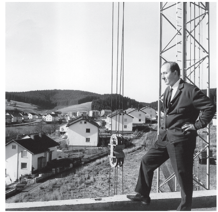
005_EF auf Baustelle Ev. Studentenheim, 1966
