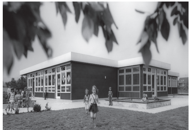
015_FF-Kindergarten in Tafelbauweise + Raumzellen
