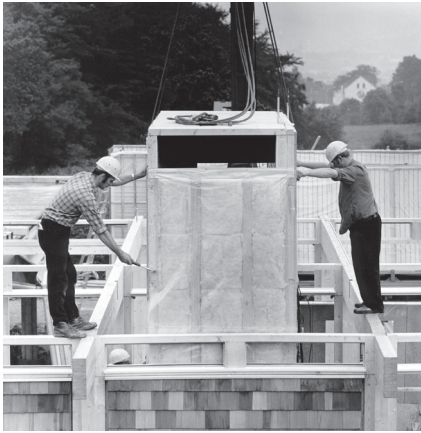
035_FF-Modulsystem_Montage Raumzelle
