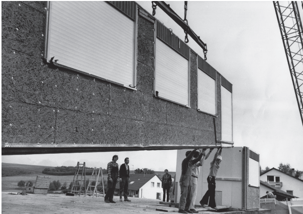
018_ FF-Typenhaus_Montage Wandelement
