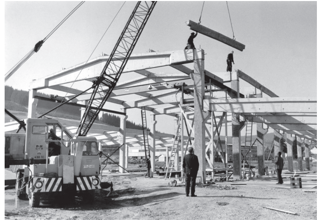
014_Errichtung Werkhalle in Stahlbeton-Fertigteilen, 1966
